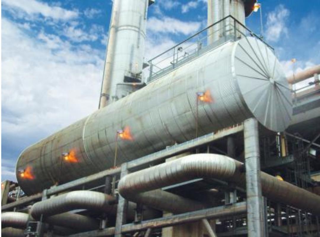
在蒸馏塔的预热系统中，一个预闪蒸罐系统将预热前产生的蒸汽与加热器或主蒸馏塔分开。这样可以防止加热器过热的燃烧或压力下降，减少蒸馏塔的蒸汽负荷，以免水淹。
