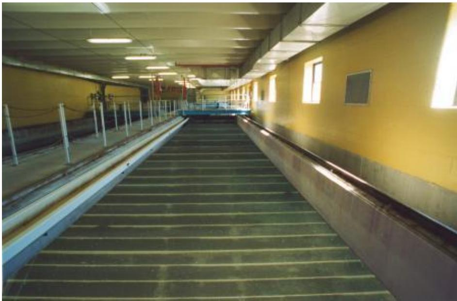
在水处理净化完之后，预过滤水从入口通道进入过滤床。当它通过过滤床的介质——沙或深层过滤型的无烟碳、布或表面过滤型的合成膜时，水中的细粒悬浮固体就都被清除了。
