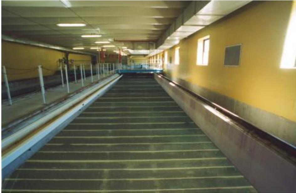
在水处理净化完之后，预过滤水从入口通道进入过滤床。当它通过过滤床的介质——沙或深层过滤型的无烟碳、布或表面过滤型的合成膜时，水中的细粒悬浮固体就都被清除了。
