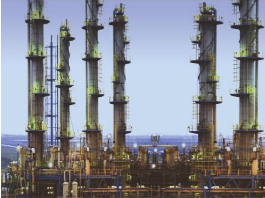
脱盐后，原油进入蒸馏塔，蒸馏会将碳氢化合物分离成不同的蒸馏段、分割段或馏分。为了使蒸馏塔达到最佳运行。
