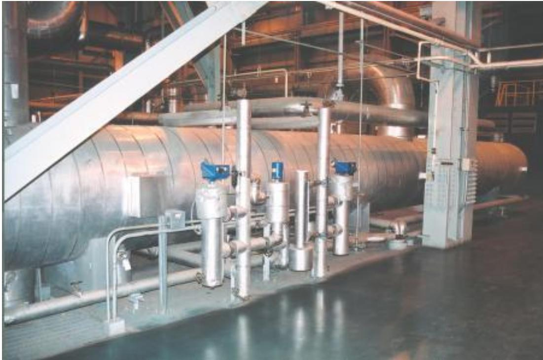
给水加热器通过涡轮机抽取的蒸汽来提高锅炉水的温度。水首先进入低压加热器加热，然后进入除氧器去除多余的氧气，再进入高压加热器，进一步加热和加压。根据 ASME 标准，每台加热器必须配置两个独立的液位控制回路。
