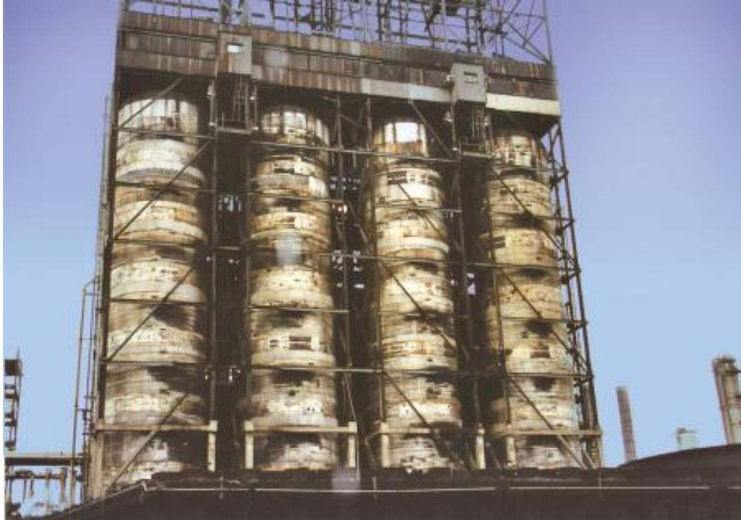
焦化是转化常减压蒸馏的最重质产物的最终手段。供料被加热并裂解为轻质气体、汽油混合原料、馏分油和柴油。延迟和连续(接触或流体)焦化的液位应用包括分馏塔、轻柴油汽提器、蒸汽、冷凝物、排污和沉淀桶以及排气分离罐。
