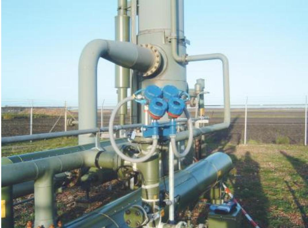
在需要汽液分离的地方，比如一个分离鼓，敲除罐，闪蒸鼓或压缩机吸鼓，会被集成为处理单元中。分离容器接收闪蒸的液体混合物，液体随后被重力分离，从顶部蒸汽出口下降到底部。
