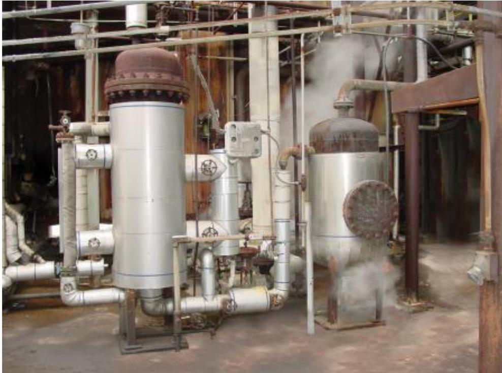
热交换器从分馏塔的上部抽取蒸汽，将其冷却成液体，并将其泵入储液器（回流罐）中。然后由回流泵从储液器的底部抽取液体，将一部分泵回（回流）重新引入到塔中的较低点。这种回流过程是通过确保足够的液体向下流动以满足蒸气的上升，从而提高分馏塔的分离度。
