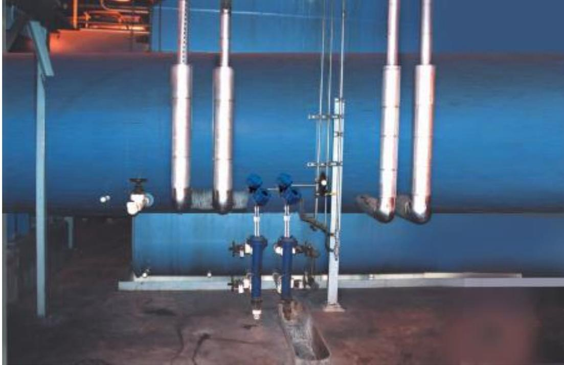
蒸汽在进入低压给水加热器之前会先进入凝汽器冷却并冷凝成水。凝汽器热井充当涡轮机循环的一个蓄水池。当热井液位达到最低点时，阀门打开，为循环提供补给水。当热井的液位达到高位范围时，打开排水阀将冷凝水从热井排至冷凝水储罐。
