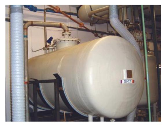
为保护周边的供水系统,工业废水在排放前必须被中和成既不是酸性也不是碱性。 在一个装有废水的水槽中加入酸和碱的试剂,就会发生中和反应。硫酸、氢氧化钠和碳 酸钙是最常用的添加剂。
